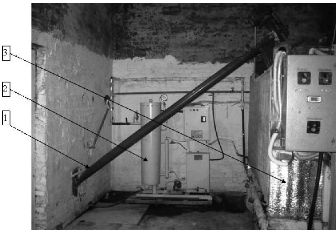
Рис. 1 – Установка для осолаживания концентрированных кормов: 1 – шнек; 2 – электрокотел; 3 – смеситель
